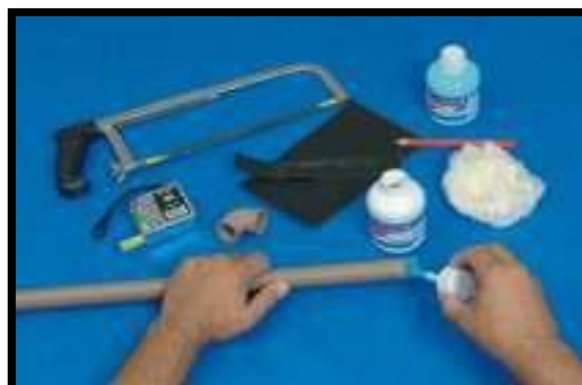
Figura 3. Execução da Tubulação Soldável
