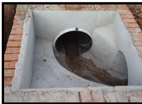
Figura 10. Execução do fundo das caixas de passagem
