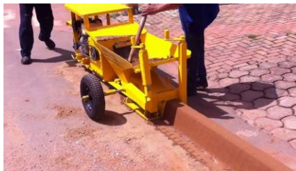
Guia de meio fio com extrusora
